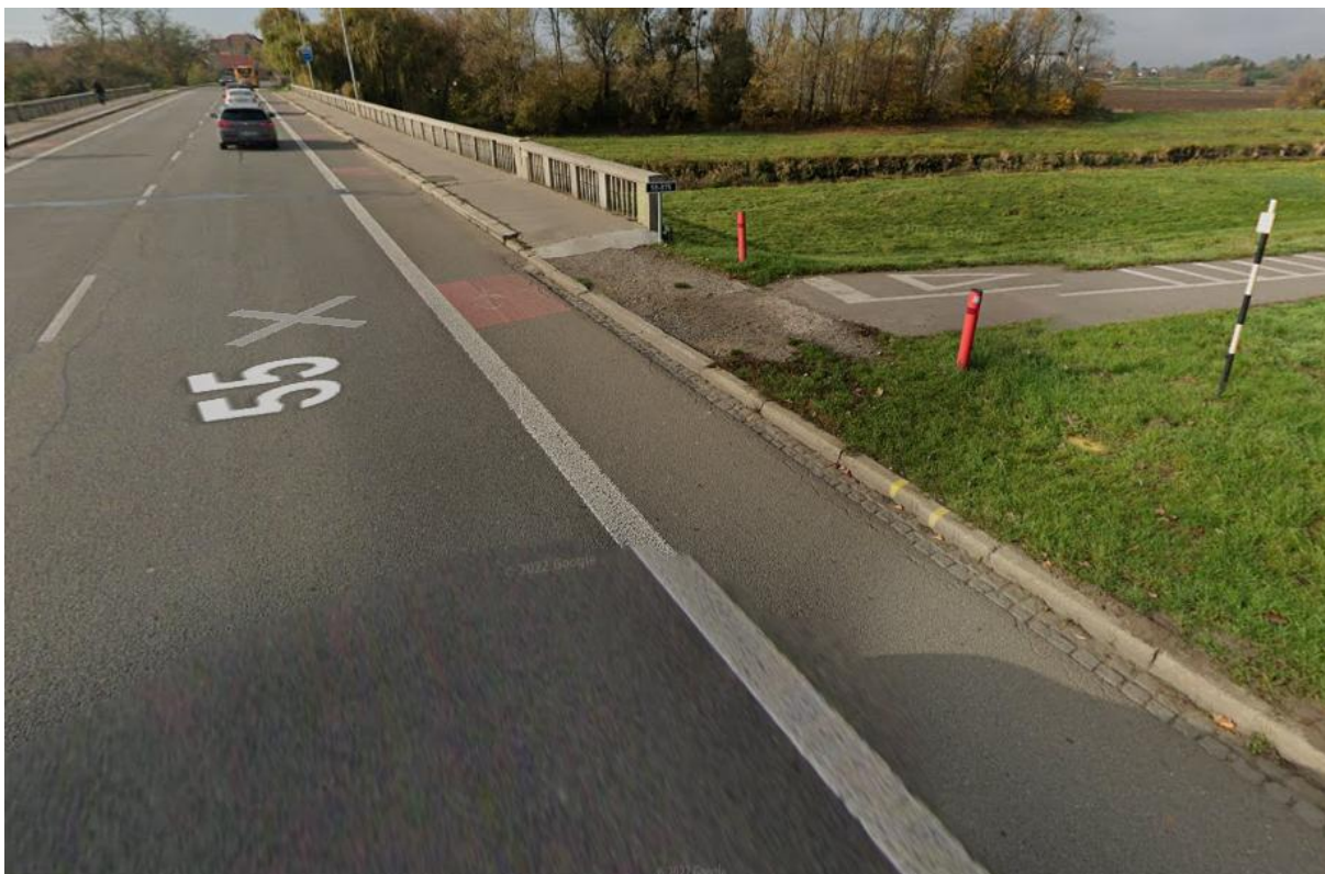
Chybějící mimoúrovňové křížení silnice I/55 (zdroj: google.com)
